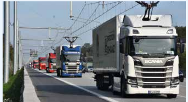
Auf der ELISA Teststrecke wird der Einsatz von Oberleitungs-Lkw erprobt. (Foto: HMWEVW)
