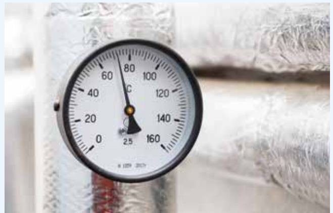
Die Temperaturanzeige gibt Auskunft über die Temperatur im Wärmespeicher. (Foto: vladdeep / stock.adobe.com)
